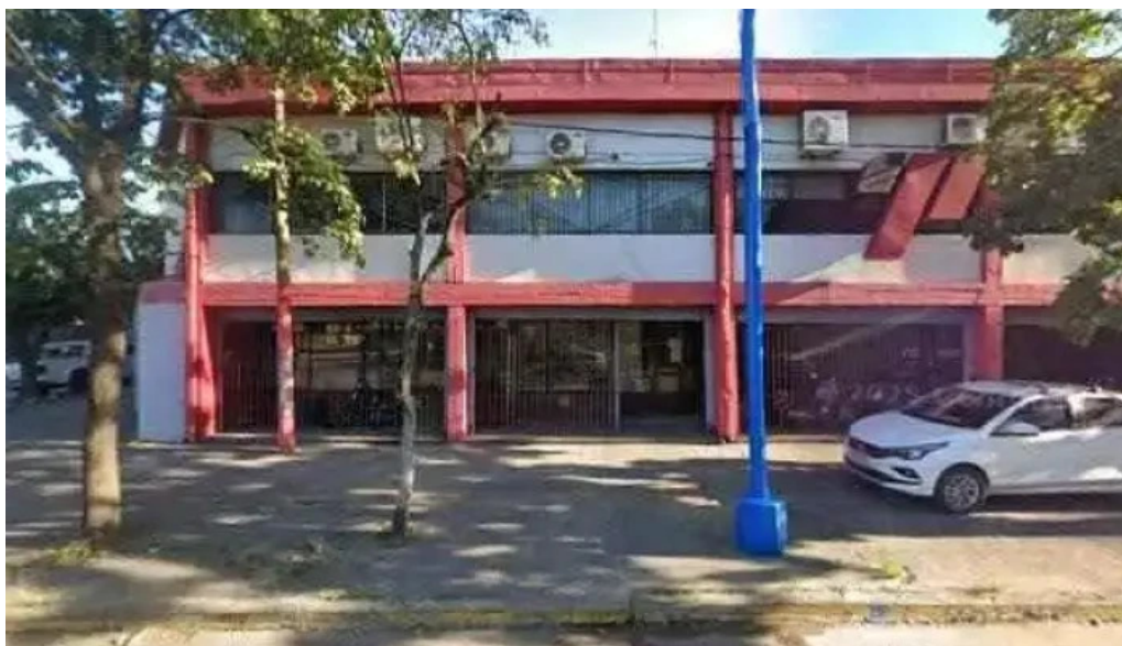
Puertas srl montajes y servicios industriales comentariosdeg
