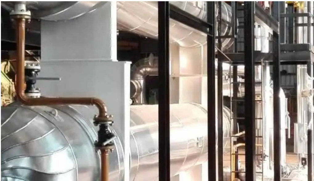
Estructuras metalicas ssyme de mario abella donde
