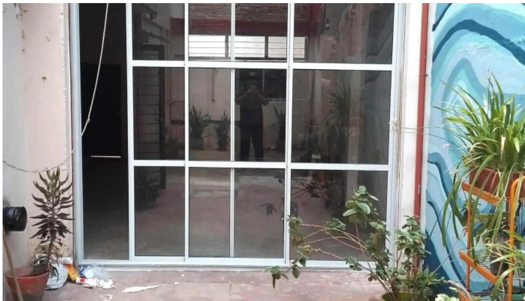
Aberturas san jose cerca de mi
