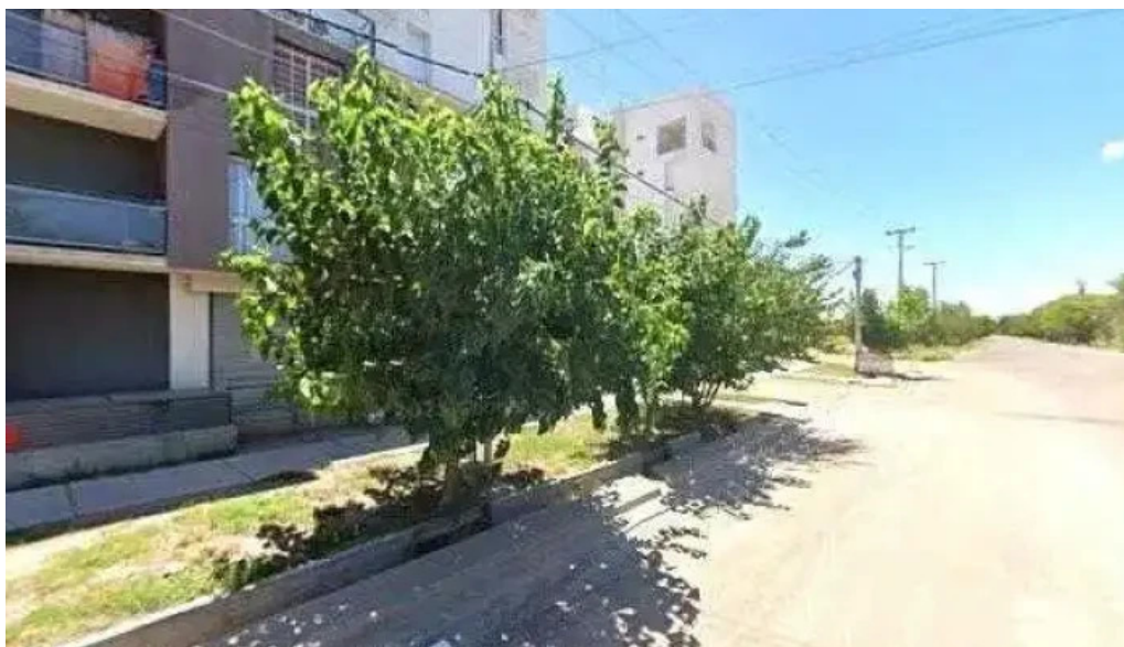
Cerrajería avenida fotosdeg
