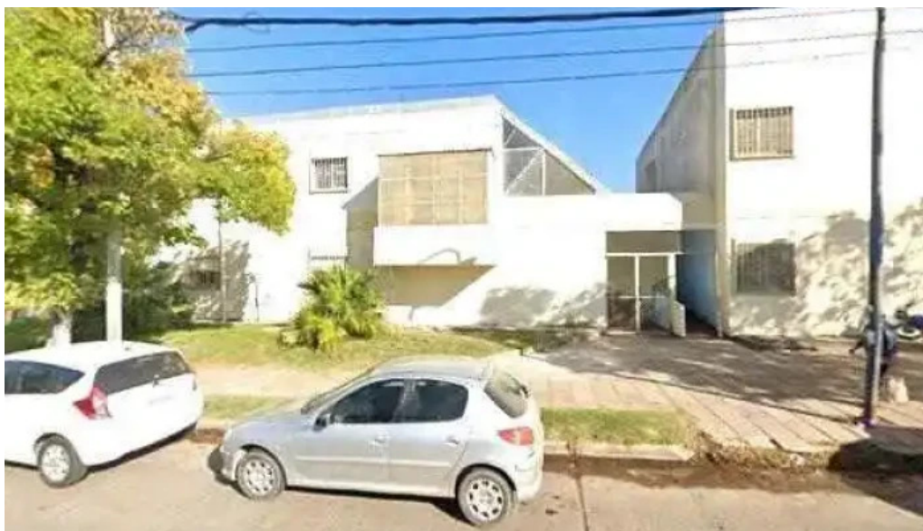
Cerrajería artigas ubicaciondeg
