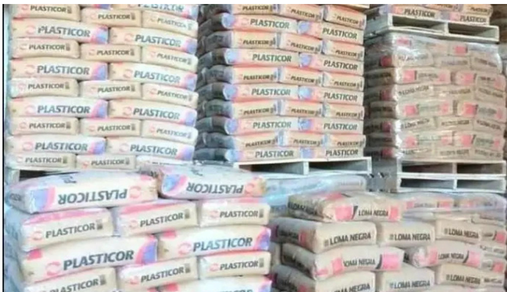
Materiales avenida del propietario
