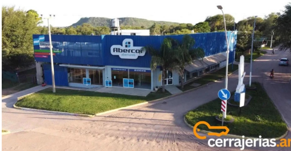
Abercor aberturas villa del dique
