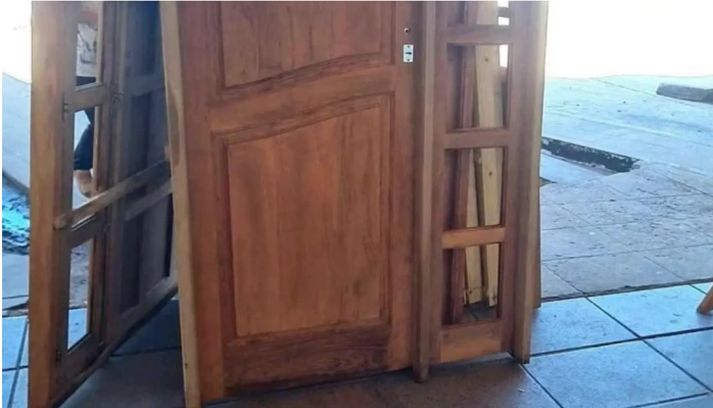
Aberturas de algarrobo las 2 f del propietario
