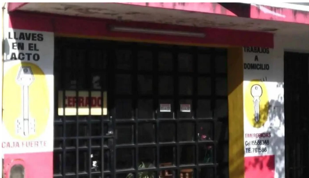
Cerrajería trabex exterior
